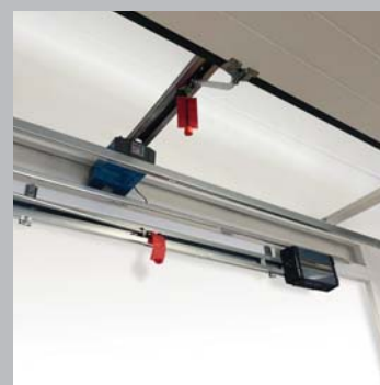
Motor en caña de puerta seccional vertical y lateral
